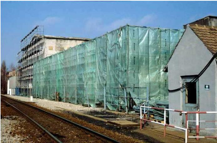
*Die Gebäude der ehem. Metallhütte wurden mit einer sog. Einhausung versehen, damit während des Abbruchs keine Schadstoffe in die Umgebung verweht werden.*
