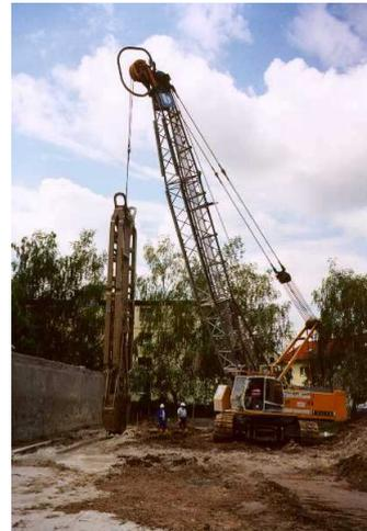
*Ein Schlitzwandgreifer hebt die Gräben für die Dichtwände aus.*
