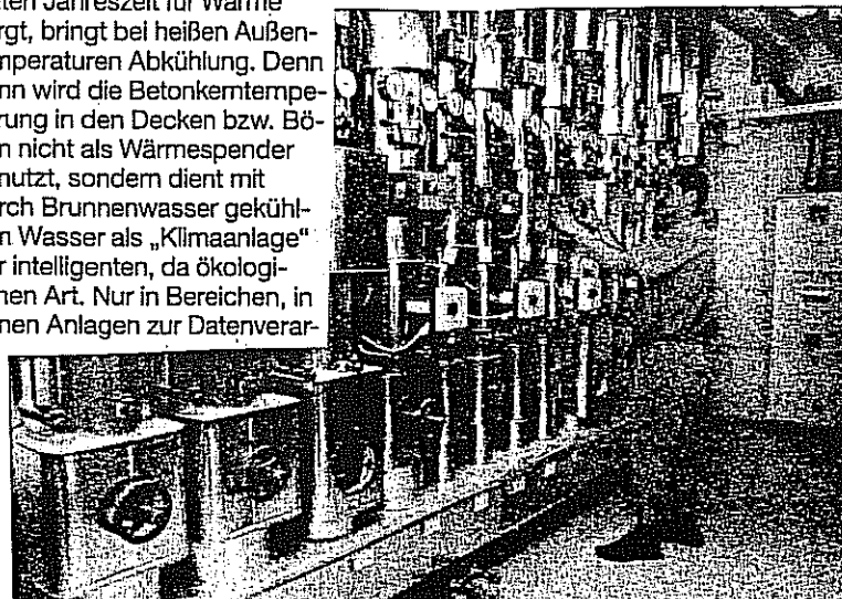
Alles unter Kontrolle hat Jovica Djuvicin in der nagelneuen Heizzentrale Wärme und Kälte für das kürzlich bezogene Gebäude kommen aus dem Boden. Fotos: Ira
