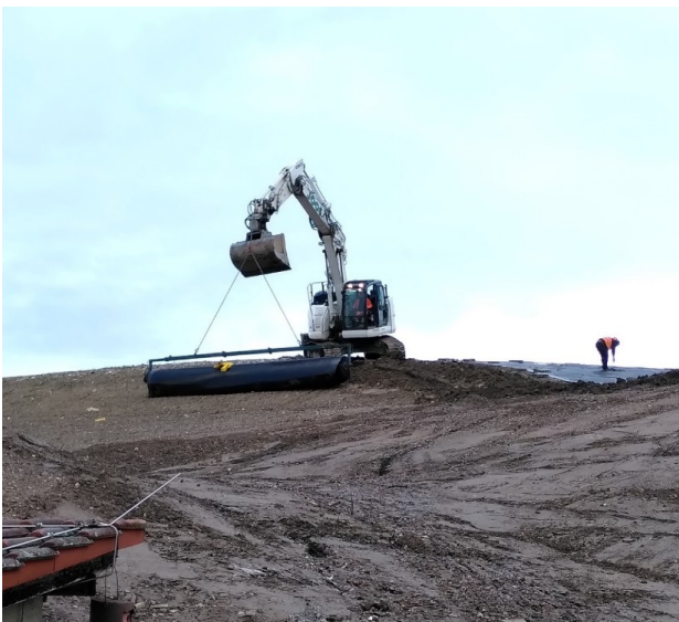
Abbildung 1: Bagger transportiert eine Rolle Folie
