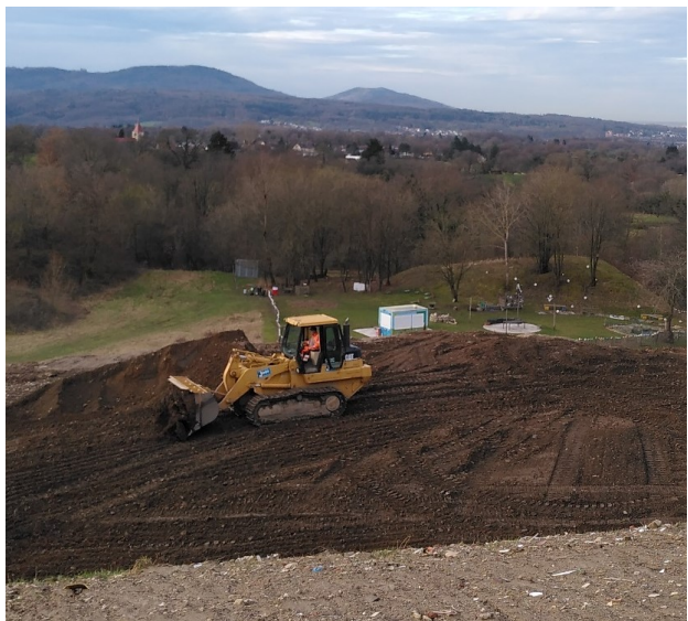
Abbildung 2: Raupe zur Profilierung von Erdmaterial
