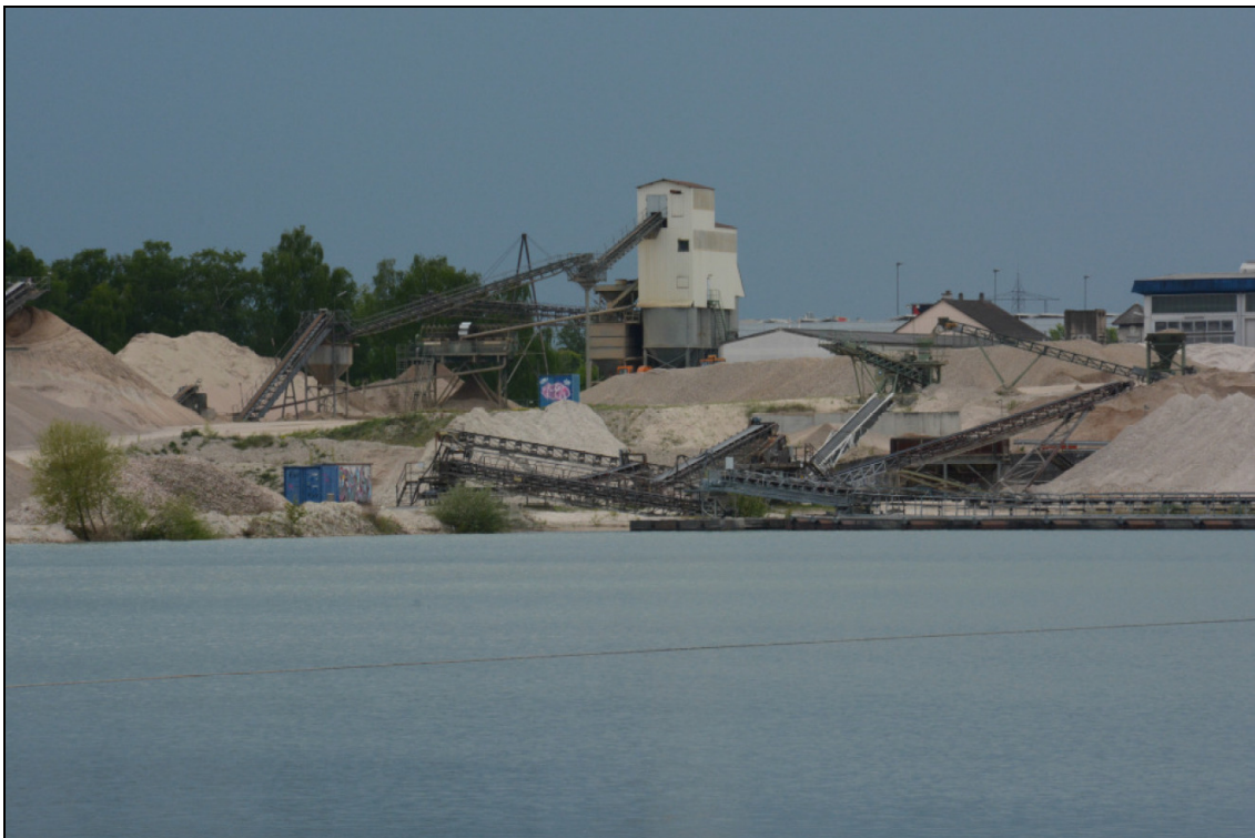
Abbildung 35: Betriebsanlagen vom See aus gesehen
