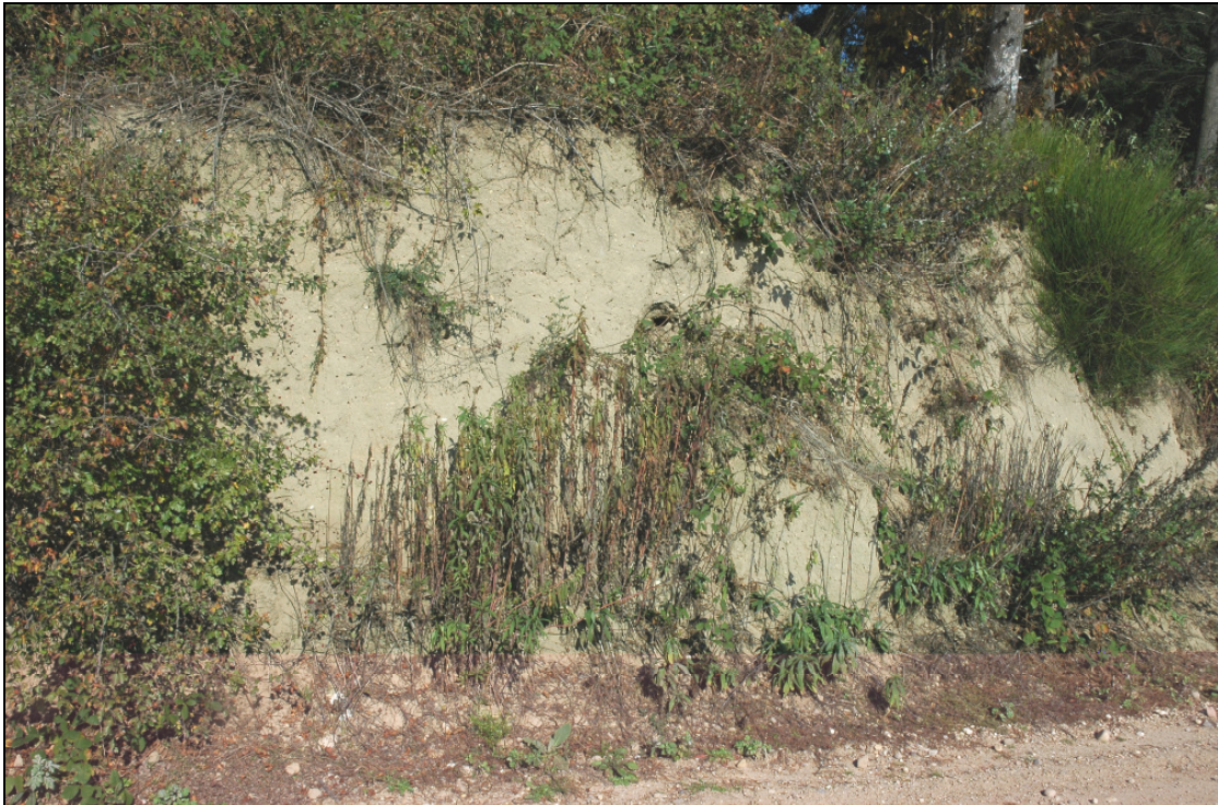
Abbildung 38: Erhaltung der vorhandenen Steilwand
