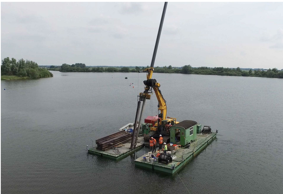
Abbildung 9: Schwimmende Plattform zum Setzen der Anker (Quelle: Verankerungssystem Knoop B.V.)
