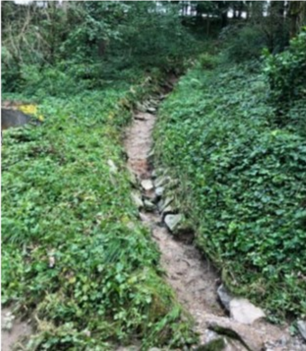
Abbildung 2: Ausgewaschene Entwässerungsgräben
