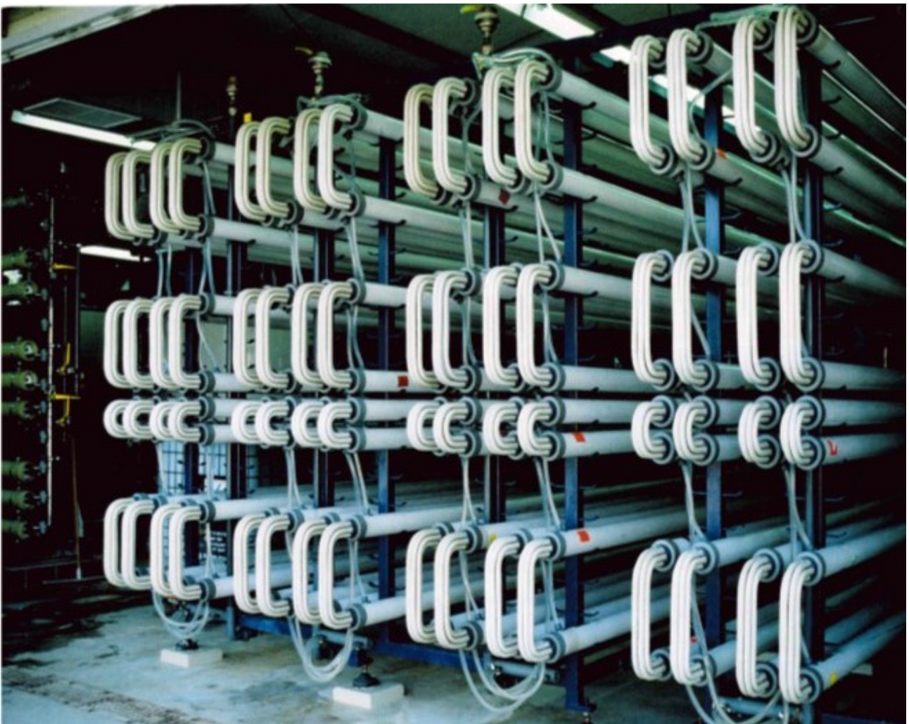
Abbildung: Bestandsgebäude mit Sickerwasseranlage (Umkehrosmoseanlage) aus dem Jahr 1986
