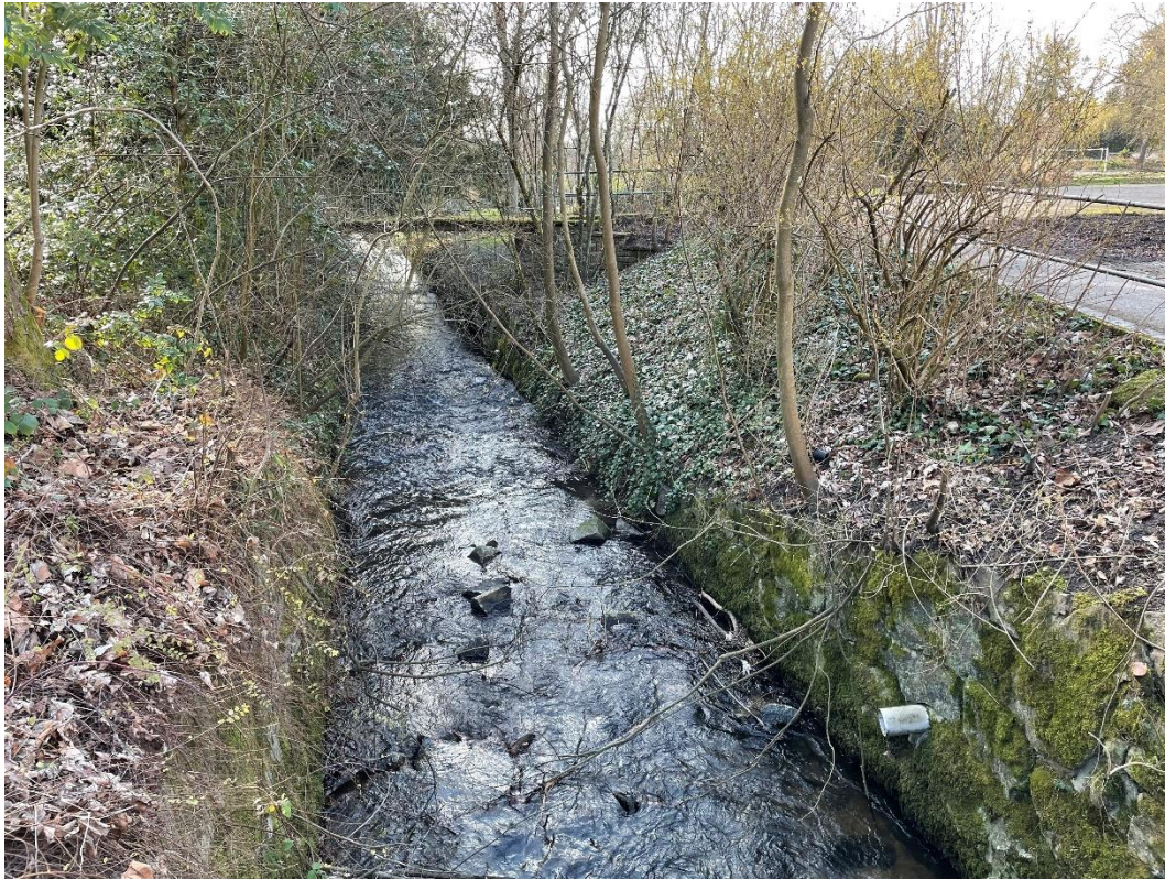
Bild 3: Kanalisierter Muhrbach unterhalb der Verdolung.
