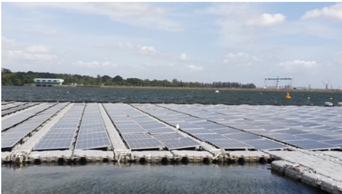
Abbildung 5.7: Schwimmende Photovoltaik-Anlage auf dem Tengeh Reservoir in Singapur (Bild: Yang et al. 2022)
