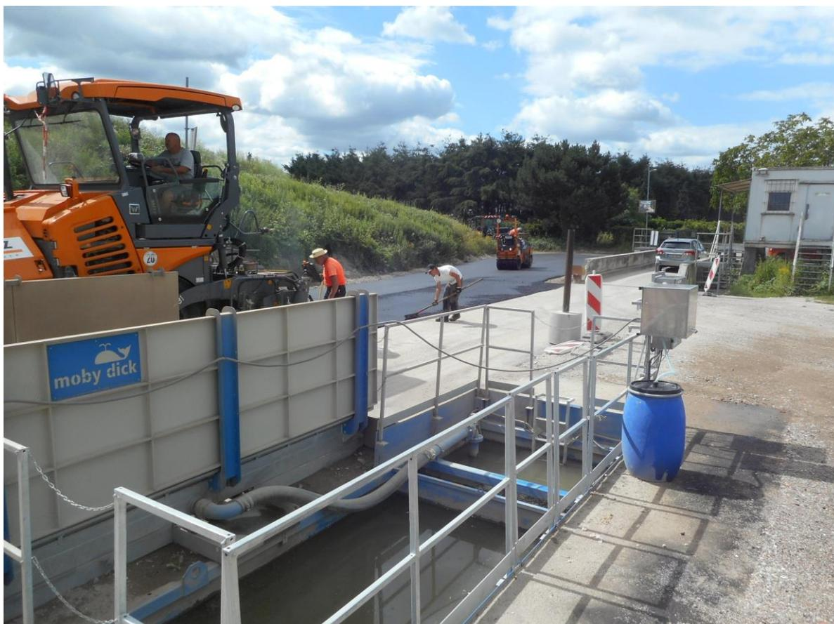
Als Nebenbestimmung zu der zwischenzeitlich erteilten Überhöhungsgenehmigung wurde durch das Regierungspräsidium Karlsruhe die Asphaltierung weiterer Flächen im Umfeld der Reifenwaschanlage, der Waage und der Deponiezufahrt gefordert. Hierdurch sollten die Verschleppung von Schmutz und Schlamm sowie Staubemissionen weiter minimiert werden. Auch diese Arbeiten wurden zeitnah bis Juni 2018 ausgeführt.
